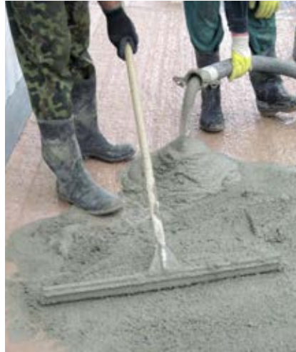
Eine Hartstoffschicht wird auf einem erhärteten Beton mit Haftbrücke verlegt.
