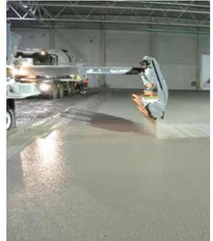
Mit Hilfe des sogenannten Spreaders wird Zuschlag auf den frischen Beton aufgestreut und später eingerieben.
