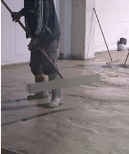
Der Hartstoffestrich wird auf den frischen Beton aufgezogen. Seine Schichtdicke und seine Zuschläge sind entscheidend für seine Widerstandskraft.
